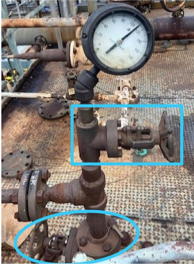
Hình 1: Van cô lập đồng hồ đo áp
