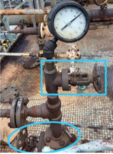
Şekil 1. Basınç göstergesini izole eden vanalar
