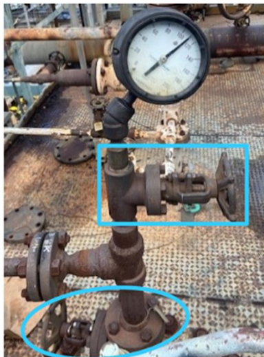
Figura 1. Le valvole che isolano il manometro della pressione
