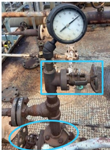
圖1：用以隔離壓力錶的閥門配置
