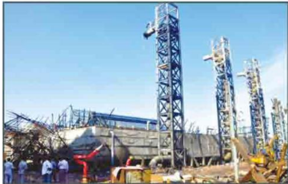
1. ábra: kiégett hűtőtorony
