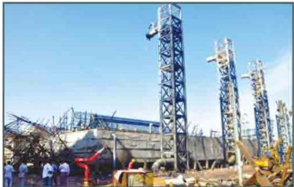
Figura 1. Incendi a la torre de refrigeració
