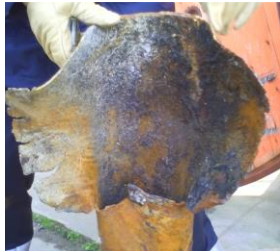
Hình 1: Ống bị vỡ
