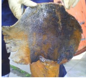
الشكل 1 يظهر أنبوبًا ممزقًا
