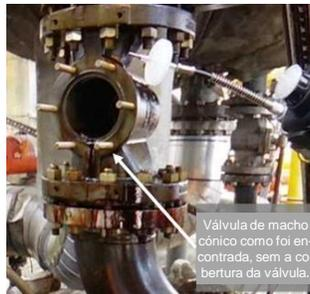
*Figura 3. Válvula após o incidente*
