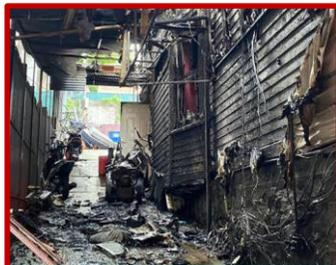
Figura 1: Danni ad un edificio provocati dall'incendio di batterie al litio.
