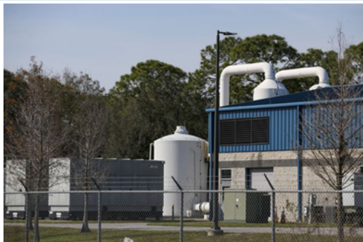
Bild 1. vattenreningsanläggning i Oldsmar, Florida
